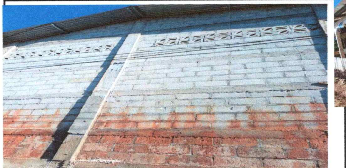
Foto 6: se observa el deterioro de las columnas y paredes exteriores
